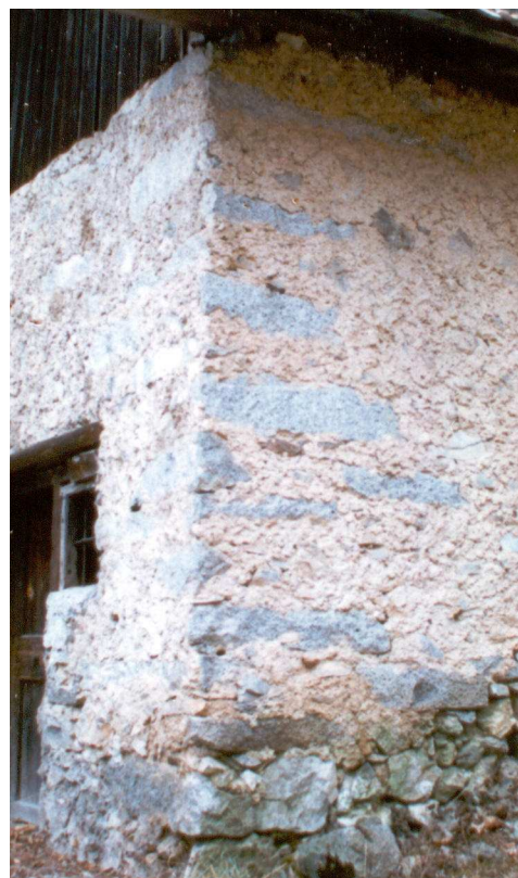
Particolare intonaco «raso sasso»
